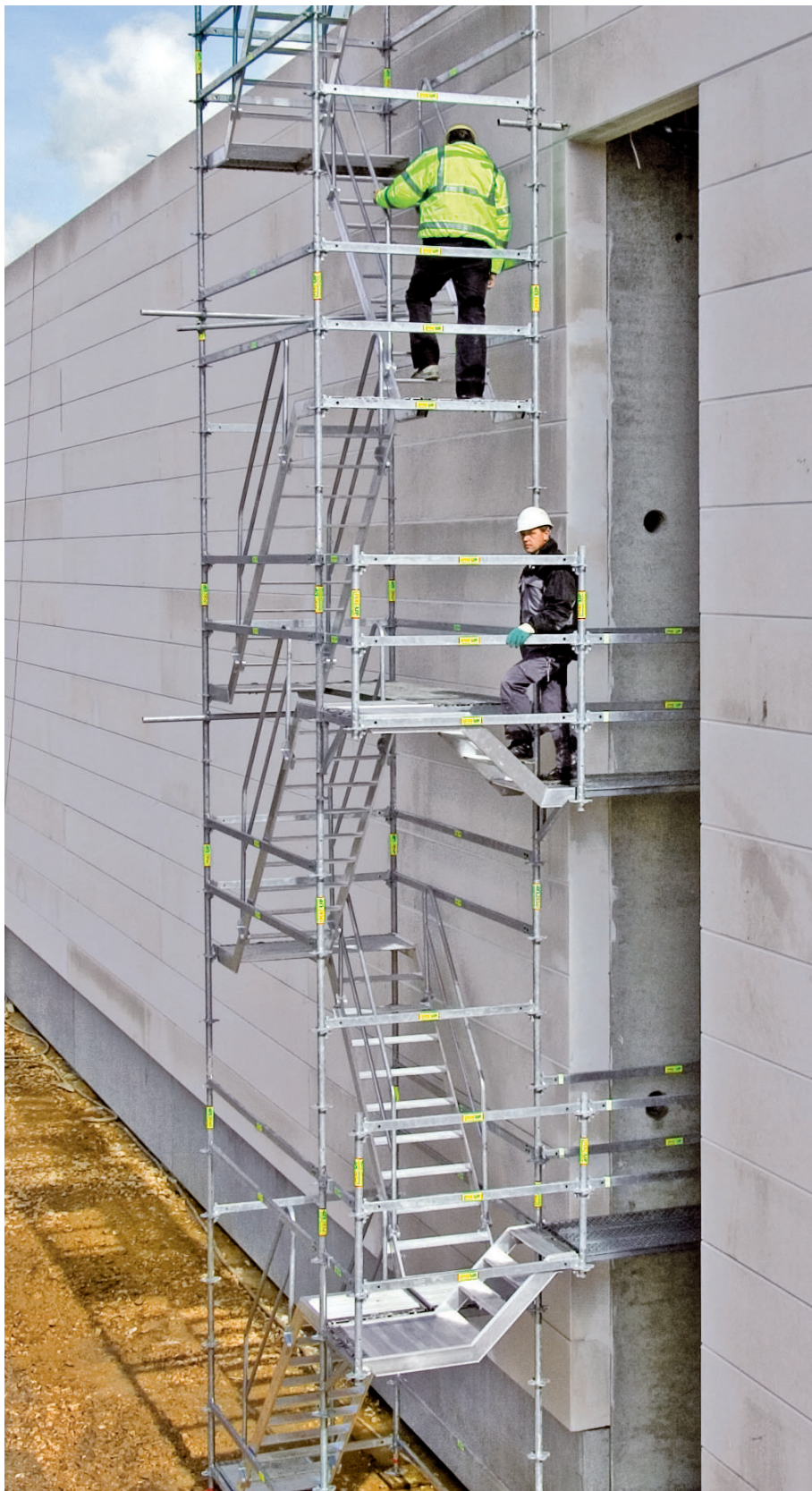
Las adaptaciones de altura en aberturas de edificios se montan independientemente de la altura de los pisos.
