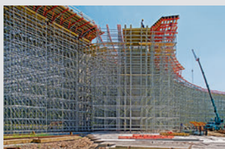
Cimbras y torres de carga
