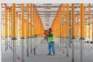
Encofrados para losas
