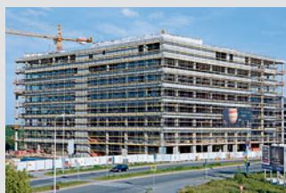
Andamios de trabajo para fachadas
