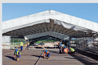
Andamios de protección
