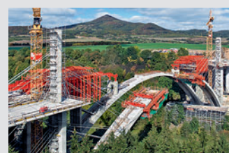
Encofrados para puentes
