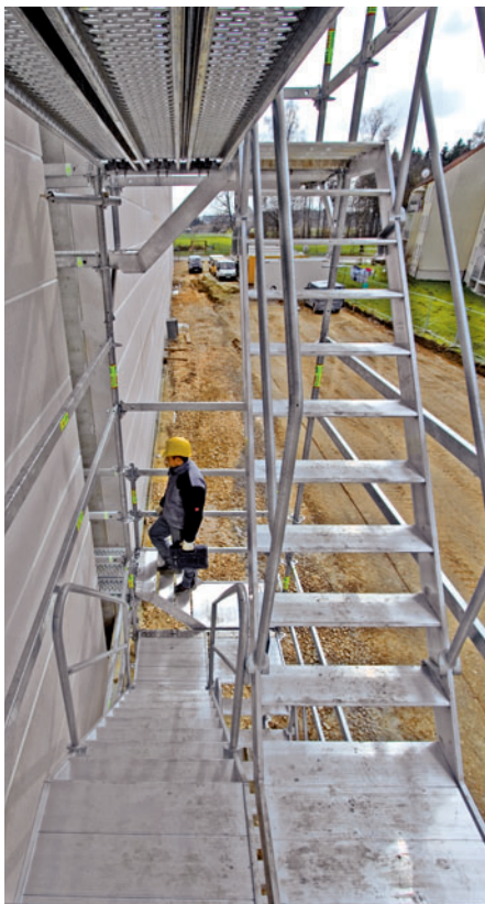
Las adaptaciones laterales de altura liberan los descansos para el ascenso y descenso.
