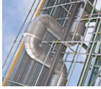
La conexión autobloqueante de los largueros en el nudo del andamio (Gravity Lock) y el seguro contra levantamiento integrado de las plataformas pueden acelerar la velocidad de montaje.
