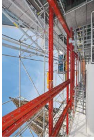
En caso de espacio limitado o terreno inestable, VARIOKIT puede utilizarse como base de carga para diversas soluciones de andamios PERI UP.
