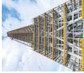
Durante su uso, la plataforma perforada antideslizante, las barandillas perimetrales y los rodapiés garantizan un alto nivel de seguridad en el trabajo.
