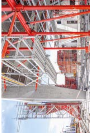
En combinación con VARIOKIT, el sistema modular de andamios PERI UP permite un acceso seguro a diferentes áreas de trabajo.
