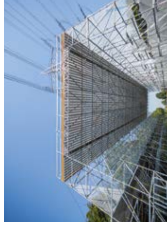
Con el práctico sistema de vigas de celosía se pueden realizar puentes con luces de hasta 8,50 m. Por ejemplo, los terrenos irregulares o las carreteras muy transitadas se pueden puentear de forma económica.
