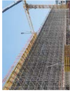
Las torres de cimbra PERI UP son compatibles con los sistemas de encofrado de losas PERI y se adaptan también a las dimensiones habituales de las construcciones de acero y madera.
