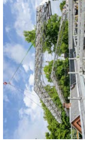
La cubierta de protección contra la intemperie PERI UP puede montarse independientemente de la subestructura. La instalación se realiza sin vigas de celosía ni acoplamientos.
