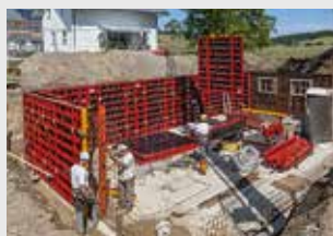
Encofrados para muros
