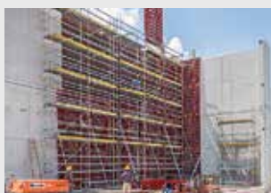
Andamios de trabajo para la construcción
