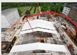
Andamios de protección
