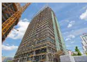
Andamios de trabajo para fachadas
