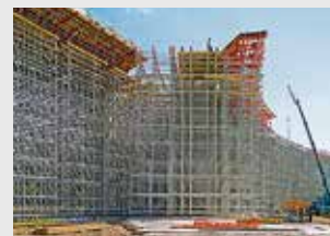
Cimbras y torres de carga
