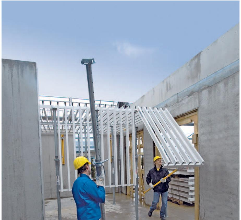
Los paneles se levantan de modo seguro y fácil con ayuda de la barra auxiliar.
