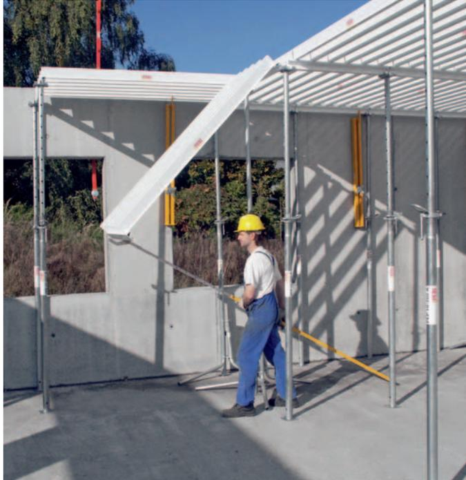
Cambiar el sentido del encofrado significa girar el panel.
