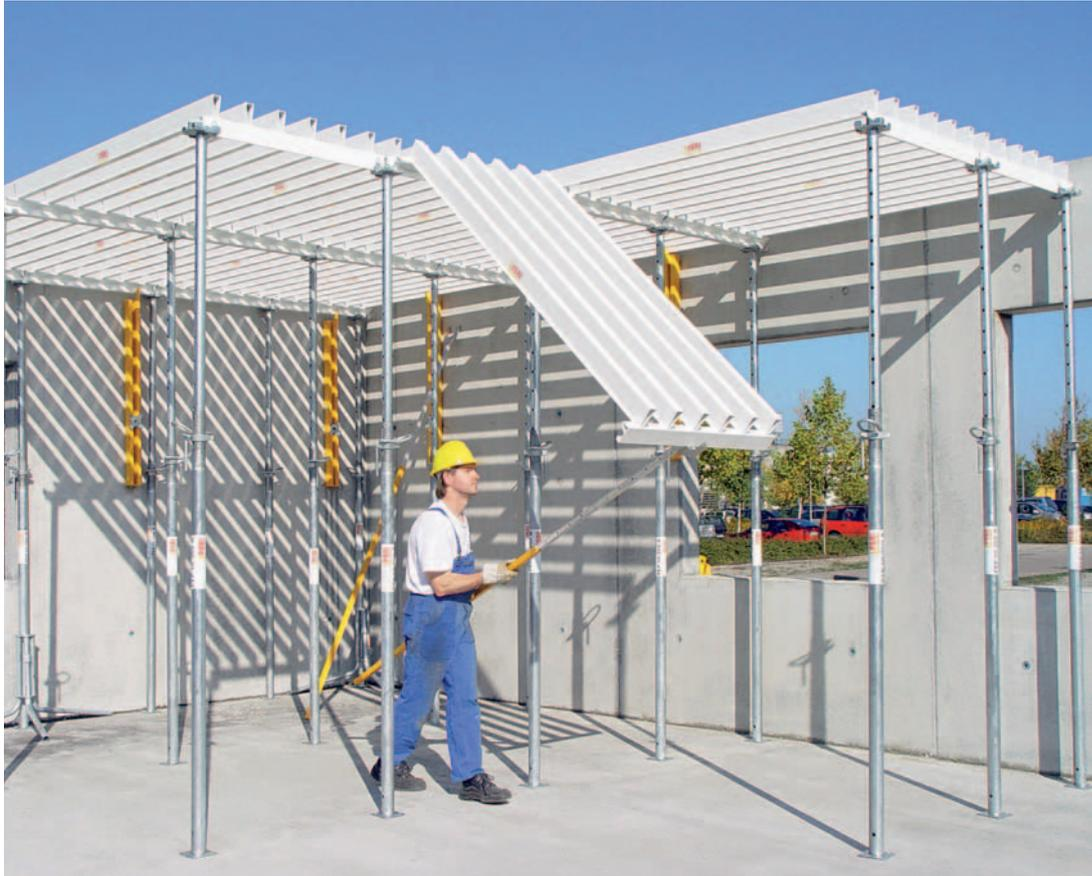
El encofrado para losas adaptable con grilla de vigas transitable y libre elección de tablero de encofrado
