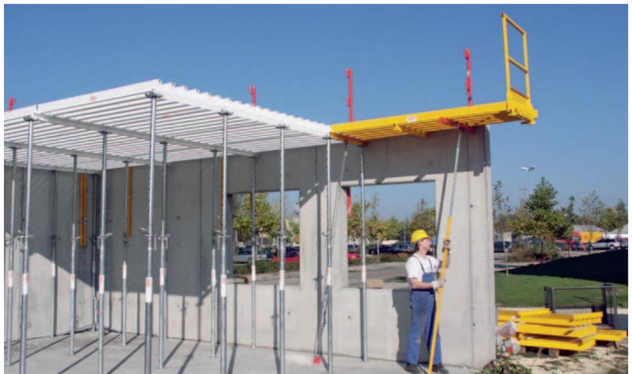
Seguridad en el borde de losa que se premonta desde abajo.
