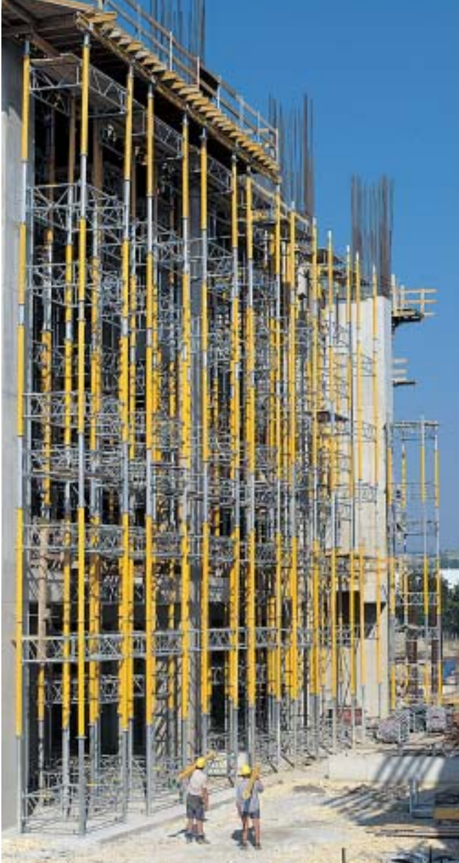
Torres MULTIPROP de 20 m de altura para apuntalar una losa en voladizo.
