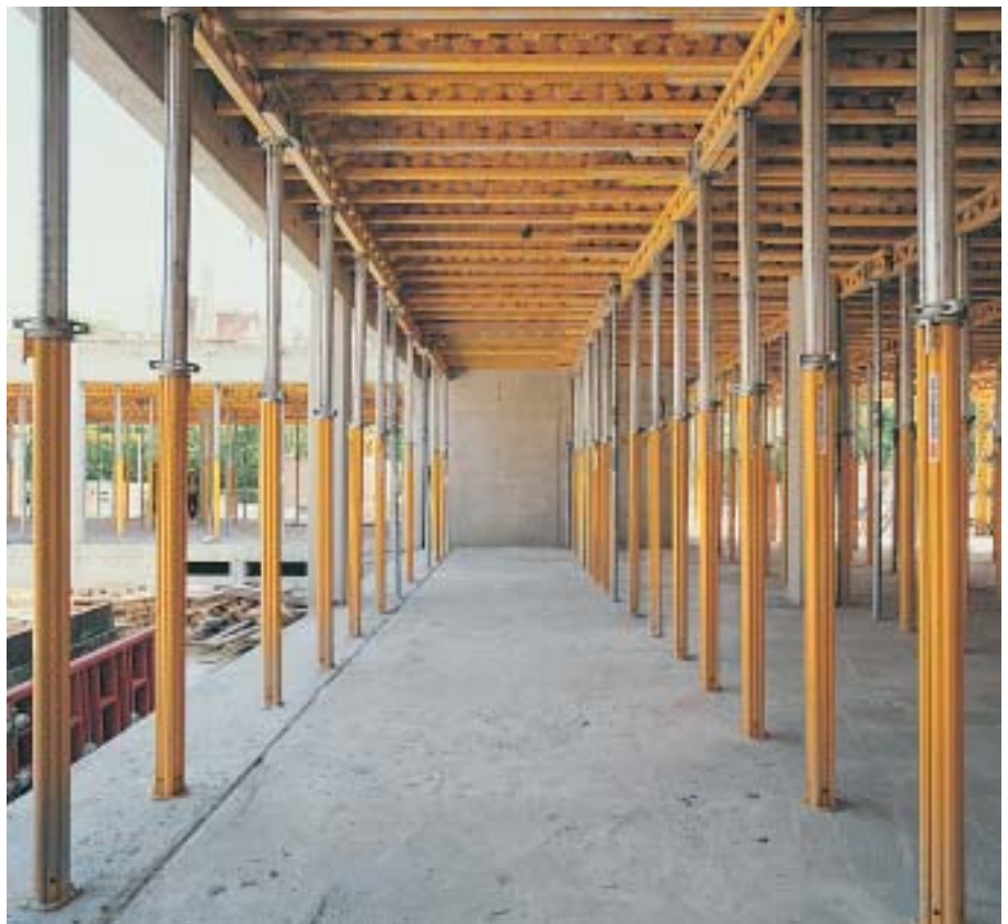
MULTIPROP 350 con encofrado para losas MULTIFLEX.
