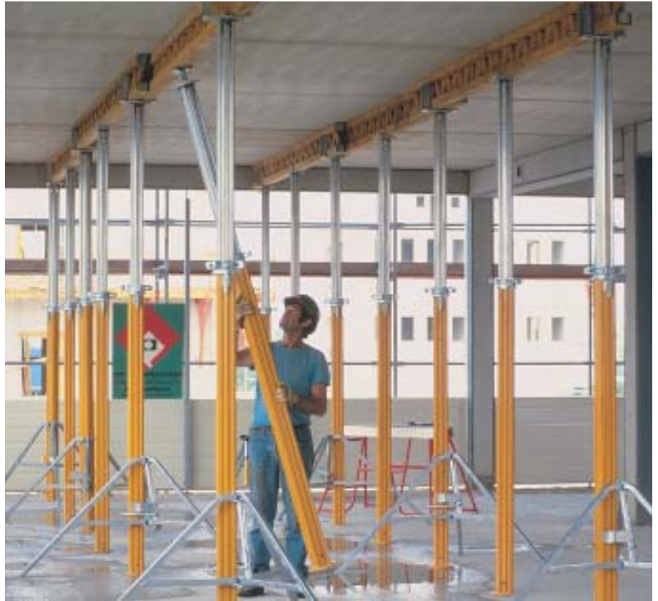
Manejo fácil y cómodo del MP 350 por un solo hombre. El peso de tan sólo 18,8 kg lo hace posible.
