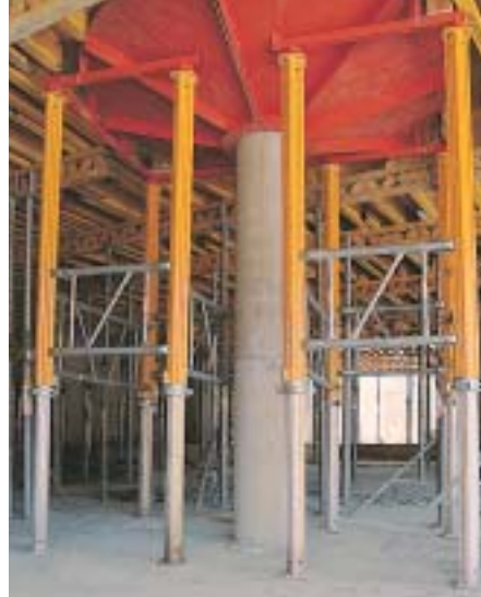
MULTIPROP 350 con marcos para el apuntalamiento de un cabezal tipo hongo.
