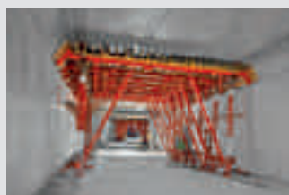
Encofrados para túneles
