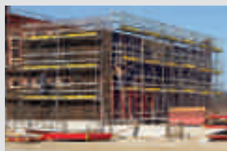
Andamios de trabajo para la construcción
