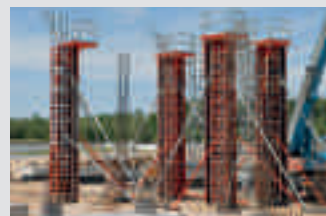
Encofrados para pilares y columnas circulares
