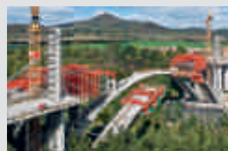
Encofrados para puentes
