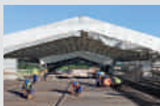
Andamios de protección
