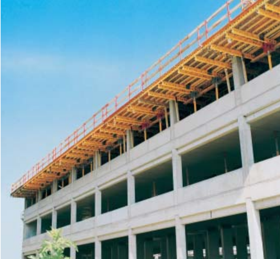
Mesa de borde UNIPORTAL con voladizo y protección contra caídas.
