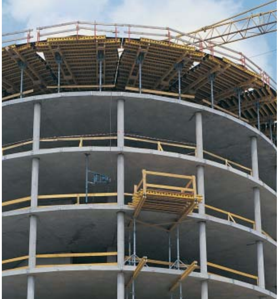
Mesas trapezoidales para un edificio de oficinas circular. Tamaño de mesa: 7,00 x 4,65/2,50 m.
