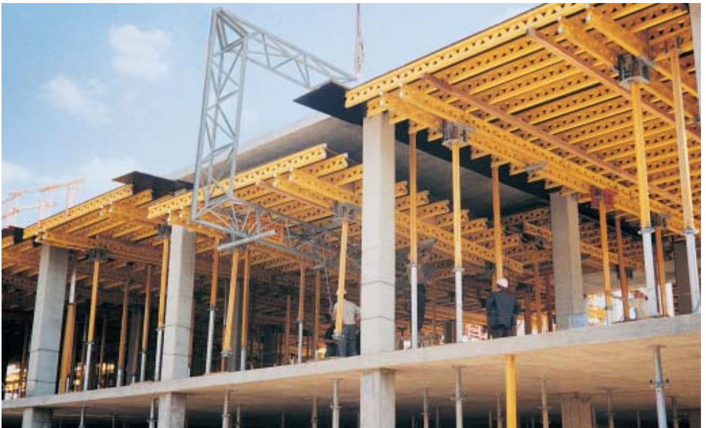
Mesas para forjados UNIPORTAL de 5,40 m de ancho y 7,00 m de largo.
