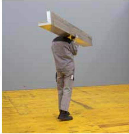
Ubicar panel de esquina interior.
