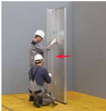
Ubicar el siguiente panel para muro con los recortes semicirculares sobre la contrarosca.
