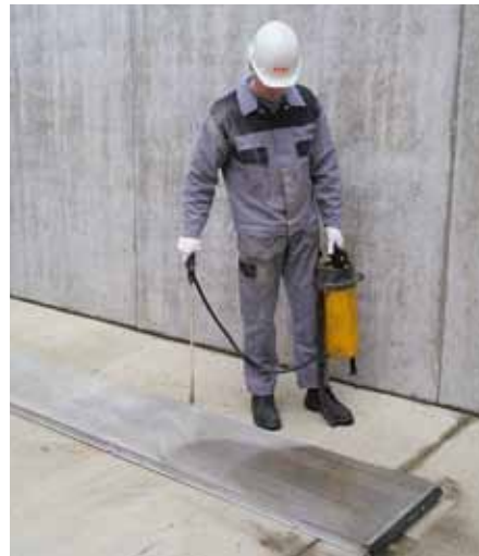
Colocar desencofrante antes de posicionar los paneles, también en los cantos.
