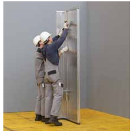
Unir el panel para muro y el panel de esquina con cerrojos para muro, cantidad según el plano.
