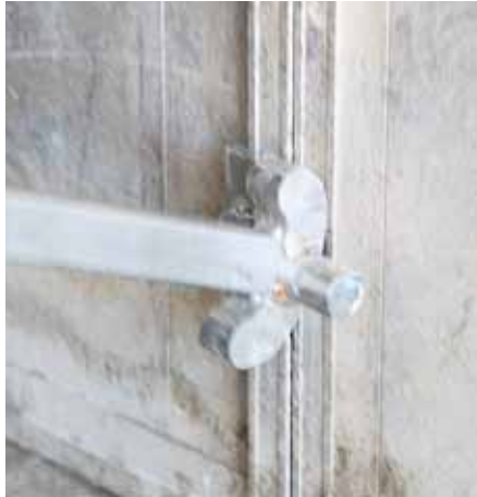
Colgar la llave de desencofrado W/S con la garra en el perfil de borde.
