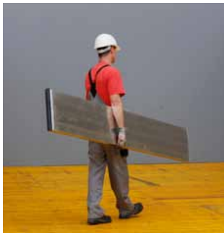
Preparar el primer panel para muro de la esquina exterior.
