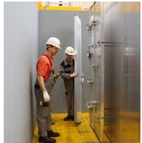
Colocar barra. Panel, cerrojos, barras de atado, etc...
