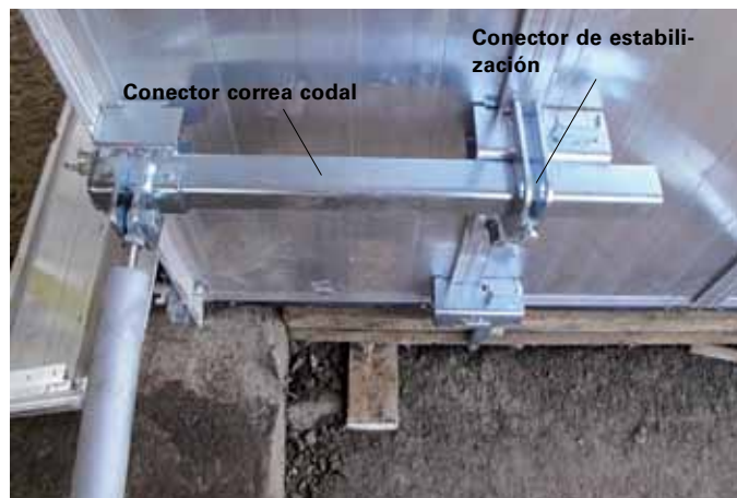
Conector correa codal para tramos de muro en ángulo recto
