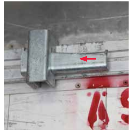
Desmontar cerrojos espaciadores. Golpear cuña hacia la izquierda.
