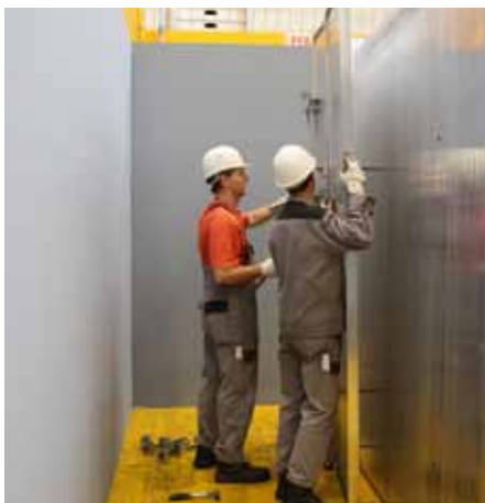
Posicionar el siguiente panel para muro.
