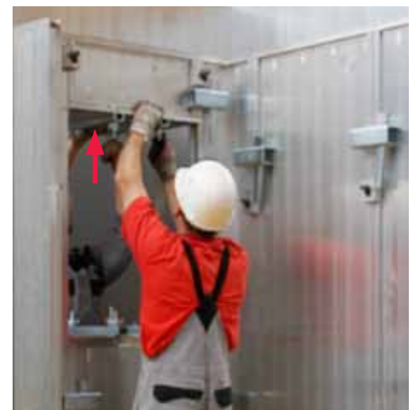
Colocar encofrado superior.
