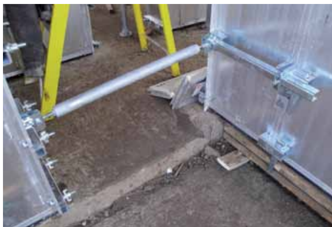
Tramos de muro en ángulo recto
