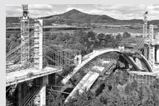
Encofrados para puentes
