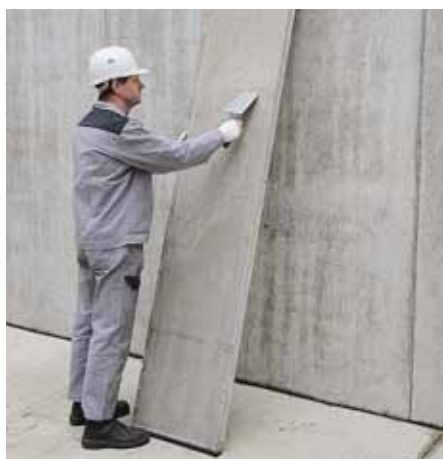
Limpiar los paneles inmediatamente después de desencofrar, p.ej. con una espátula.
