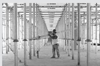
Encofrados para losas
