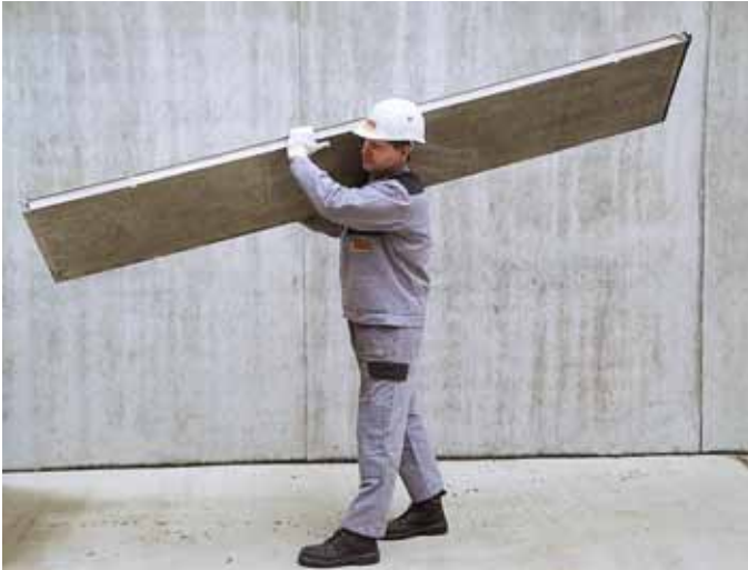
¡Los paneles siempre deben cargarse!
