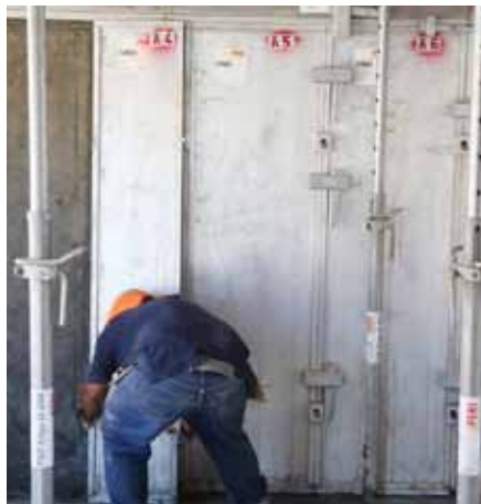
Desmontar los paneles - soltar del hormigón desde abajo hacia arriba.
