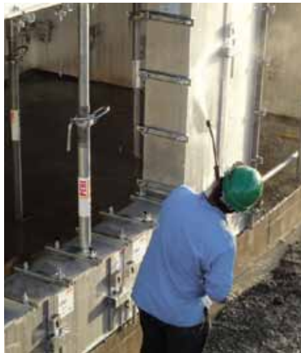
Limpiar con agua los paneles de encofrado inmediatamente después de hormigonar, p.ej. una hidrolavadora de alta presión.
