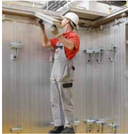
Medir la ubicación de la viga para losa.
