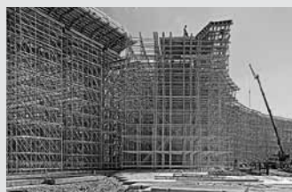
Cimbras y torres de carga
