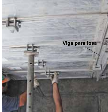
Afirmar el panel para losa en el extremo libre con una mano. Desmontar cerrojo para losa que une al panel contiguo.
