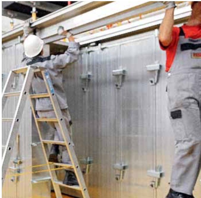
Incorporar segundo encofrado lateral de la viga de cuelgue.
