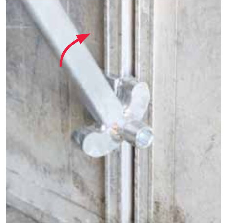
Presionar la llave de desencofrado W/S hacia arriba o abajo, hasta que el panel se suelte del hormigón.
