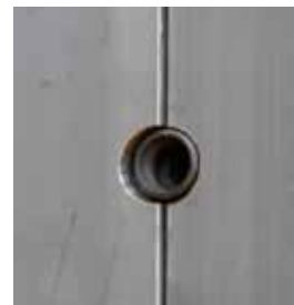
Cuando los recortes semicirculares del atado conforman un círculo, el panel para muro está ajustado en su altura.
