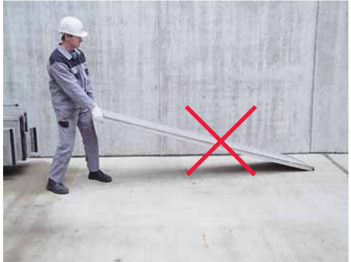
¡Los paneles nunca deben arrastrarse por el suelo!
