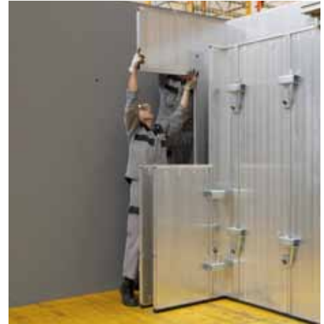
Fijar panel para dintel con cerrojo para muro.
