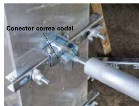
El conector correa codal está firmemente unido a la correa de tape.
