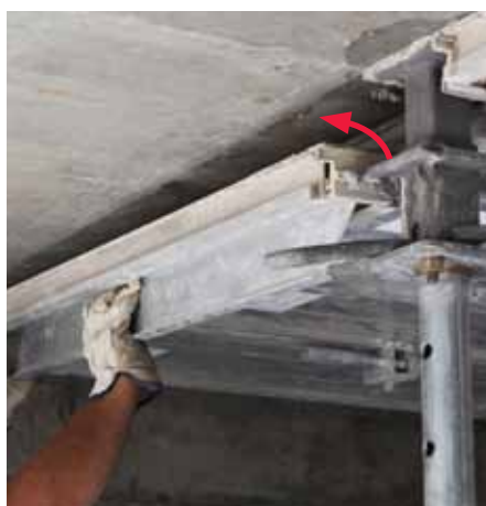
Descolgar viga para losa.
