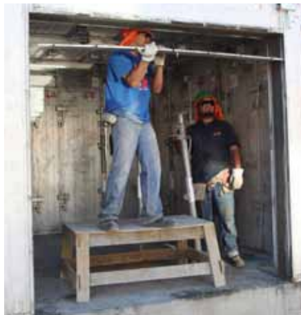
Desmontar perfiles de tape de la viga de cuelgue - retirar brevemente el puntal. Demostración estática a cargo de la dirección de obra.
