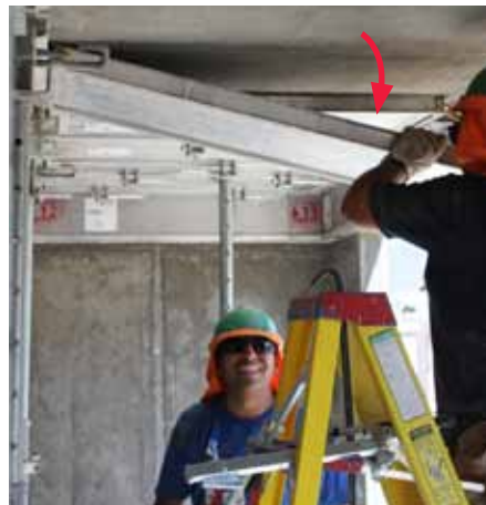
Desencofrar restantes paneles para losa.
