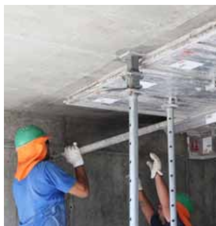
Desencofrar paneles para losa.
