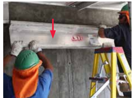
Desencofrar restantes paneles de transición.
