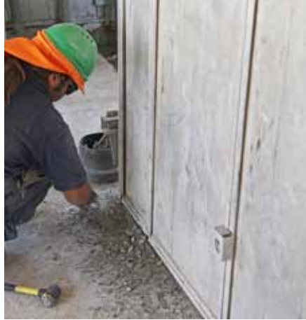
Retirar restos de hormigón.
