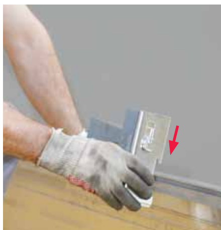
Unir el perfil de esquina exterior y el panel para muro con cerrojos para muro.
