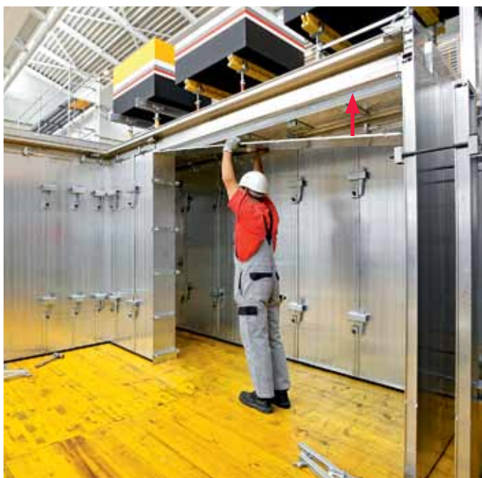
Incorporar encofrado de solera de la viga de cuelgue (perfil de tape).
