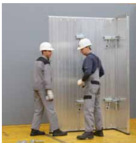
Unir los paneles con cerrojos para muro.
