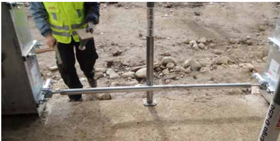
Tramos de muros paralelos
