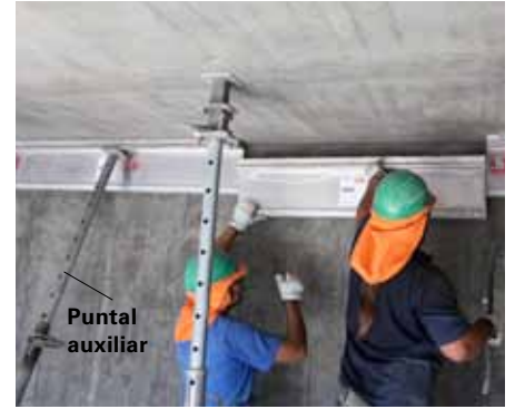
Posicionar puntal auxiliar.
