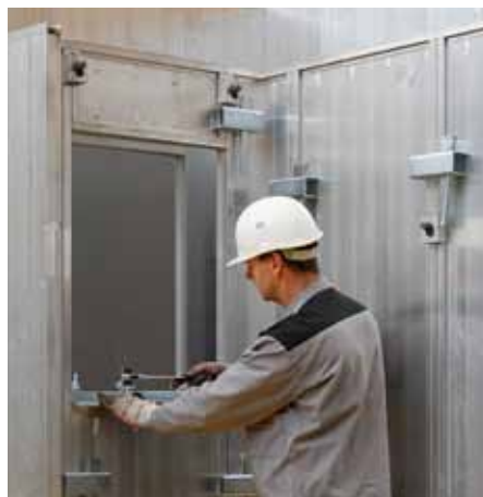
Fijar el encofrado inferior con correas de tape.
