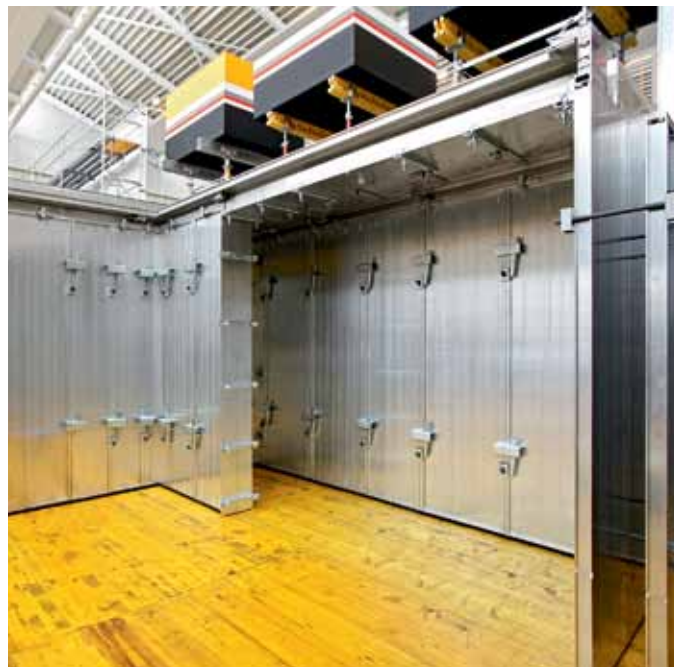
El encofrado para la viga de cuelgue está montado.
