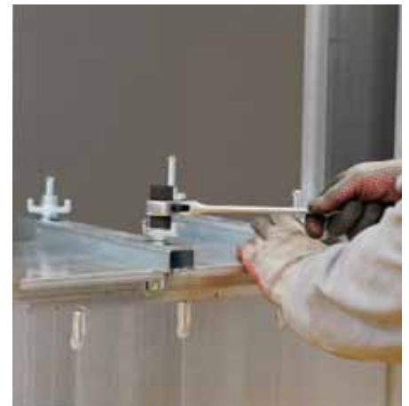
Ajustar la tuerca con la llave correspondiente.
