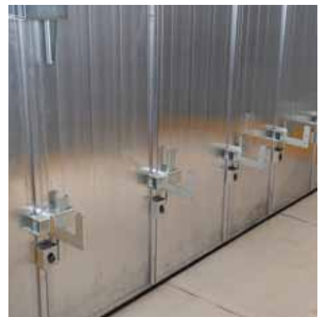
Colocar cerrojo alineador en cada encuentro de paneles. Se fija como el cerrojo para muro.
