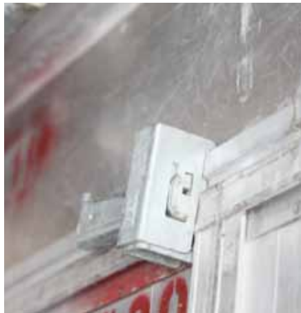
Retirar contrarosca - tirar hacia arriba la corredera bloqueadora y descolgar con un movimiento de giro.
