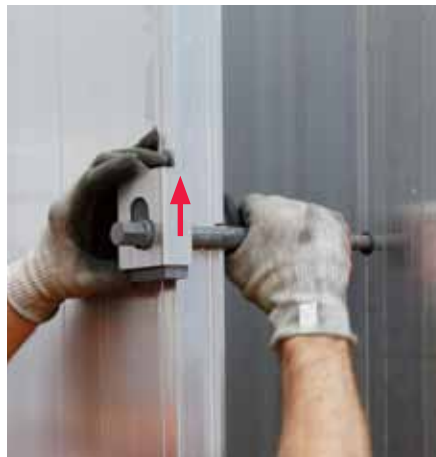
Sostener corredera bloqueadora en posición superior. Introducir la barra girando con la mano.
