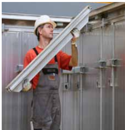
Colgar la viga para losa del panel de transición.
