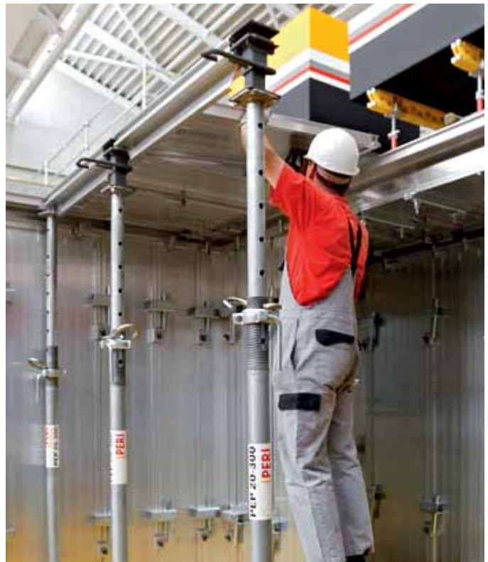
Colgar los paneles para losa y asegurarlos con cerrojos para losa.
