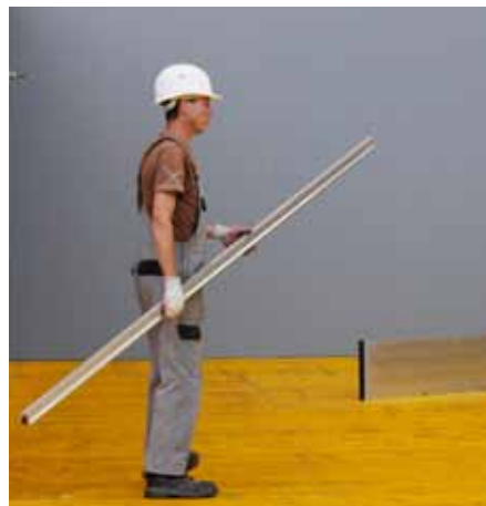
Tomar perfil de esquina exterior.
