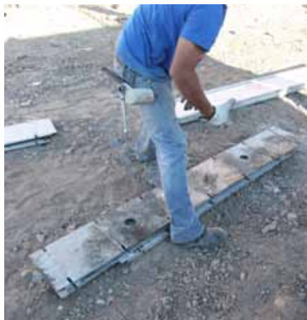
Desmontar perfiles de tape de la viga de cuelgue - retirar brevemente el puntal. Demostración estática a cargo de la dirección de obra.
