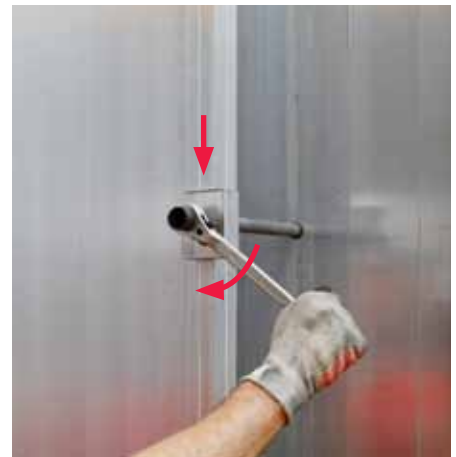
Desplazar la corredera bloqueadora hacia abajo. Ajustar con llave/ carraca.
