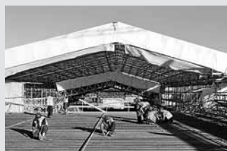
Andamios de protección
