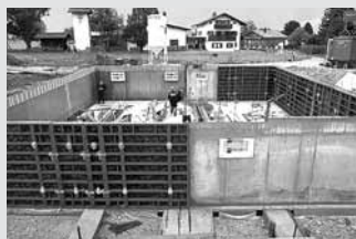
Encofrados para muros
