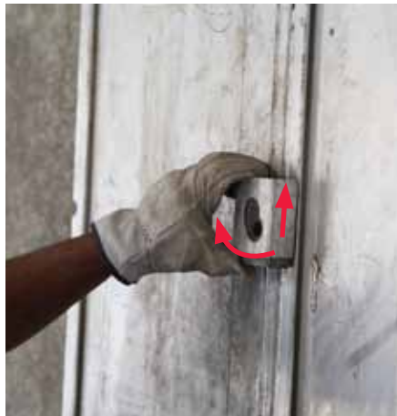
Retirar contrarosca - tirar hacia arriba la corredera bloqueadora y descolgar con un movimiento de giro.
