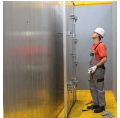
Unir los paneles con cerrojos para muro. Ajustar la barra de atado.
