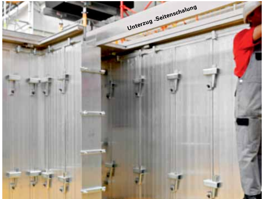
Colocar encofrado lateral de la viga de cuelgue.
