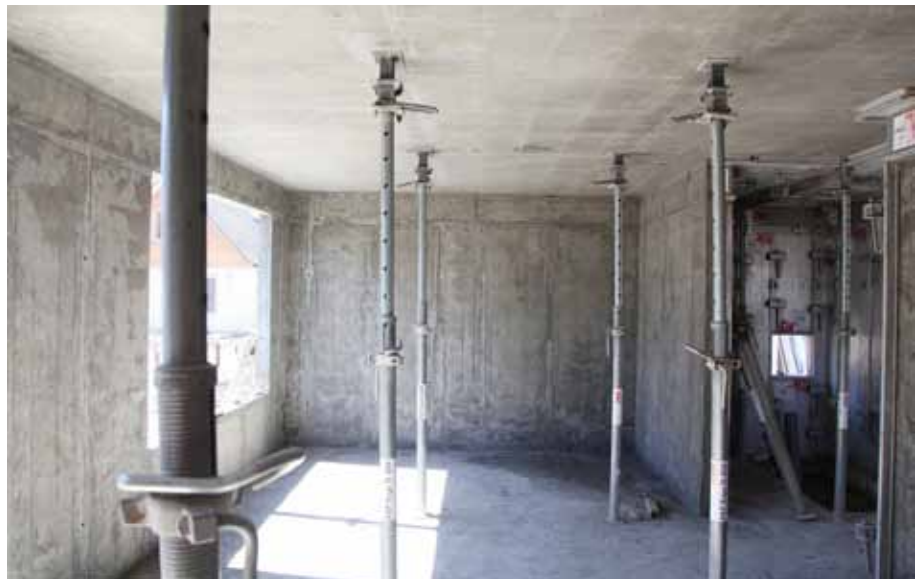
El ambiente está desencofrado.
