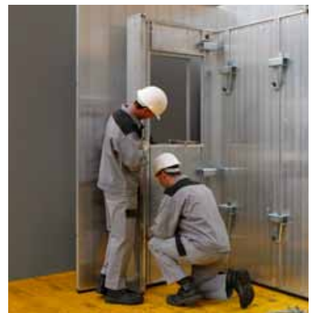
Colocar el panel para dintel interior y fijar con cerrojo para muro.
