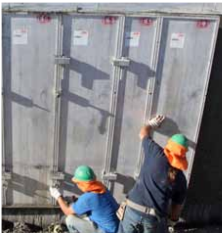
Desmontar barras de atado.
