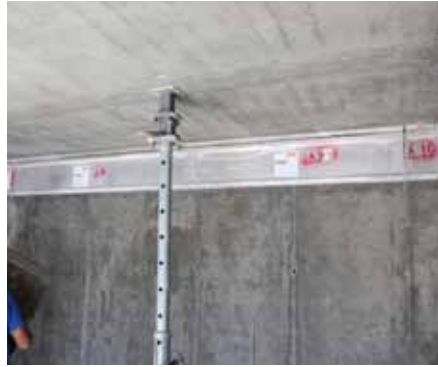
Retirar últimos paneles de transición.
