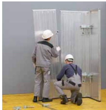
Posicionar el panel para muro.
