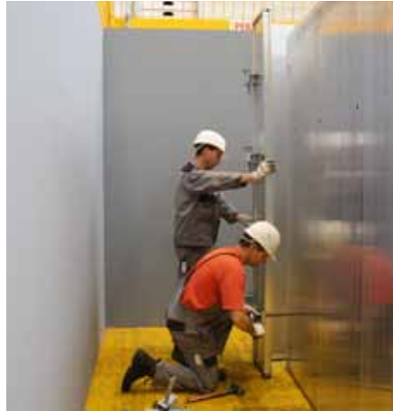
Colocar la barra de atado hasta la mitad - abajo.
