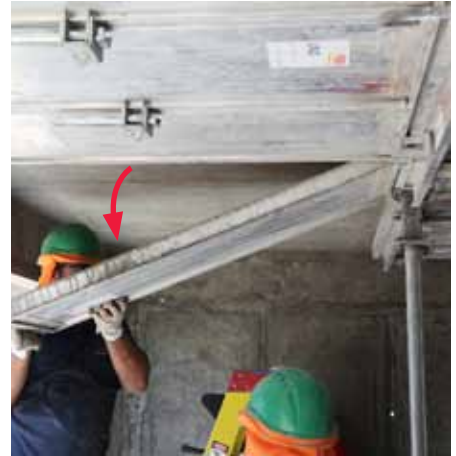
Bascular el panel para losa hacia abajo.
