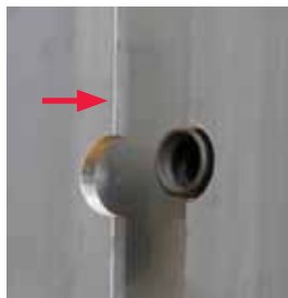
Ubicar el siguiente panel para muro con los recortes semicirculares sobre la contrarosca.
