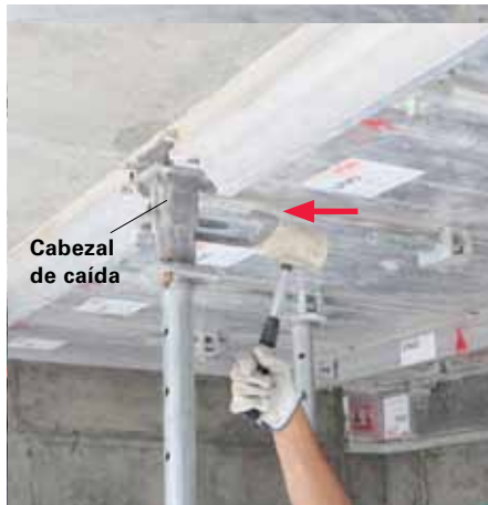
Descender cabezal de caída.
