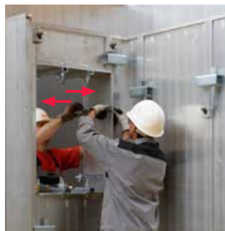
Los encofrados laterales se encuentran entre el encofrado inferior y el superior y los apoyan.
