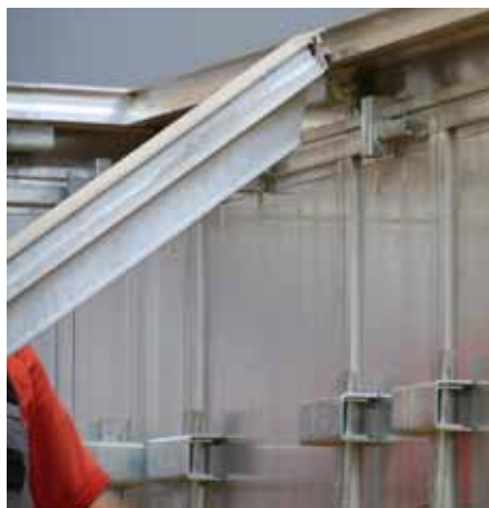
Colgar la viga para losa del panel de transición.
