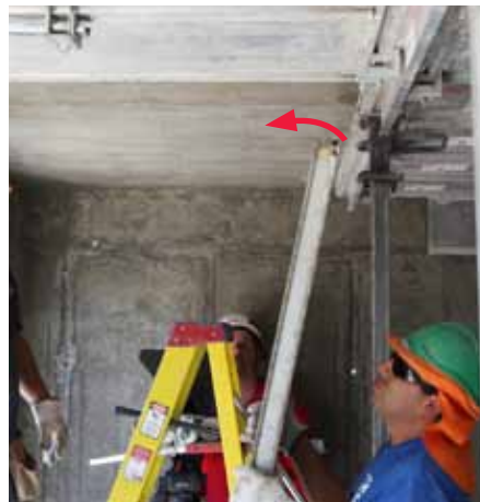
Descolgar panel para losa.
