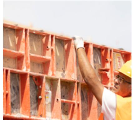
Ya sea durante el transporte o el montaje, gracias a las asas integradas en el panel, podrá coger los paneles con la mano de forma fácil y flexible.
