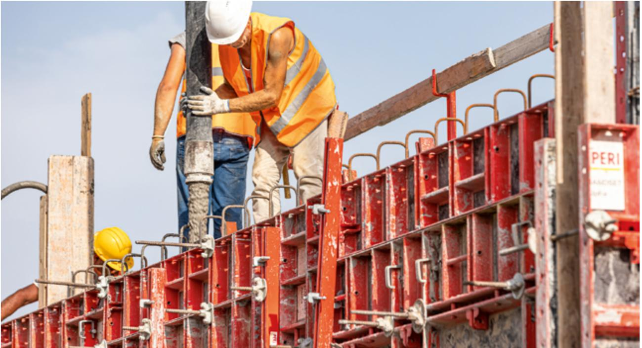
**HANDSET Alpha es un robusto sistema de encofrado básico para muros, cimientos y pilares. El sistema consta de un número reducido de componentes sofisticados y paneles multifuncionales que permiten un manejo intuitivo.**
